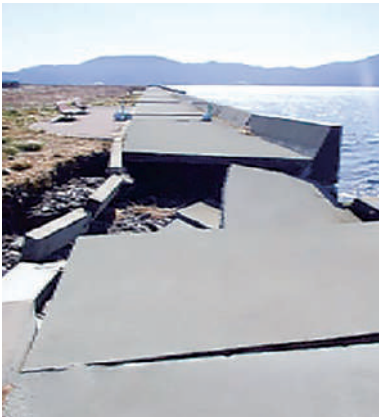
大槌漁港(大槌町) 強風・波浪による導流堤の倒壊
